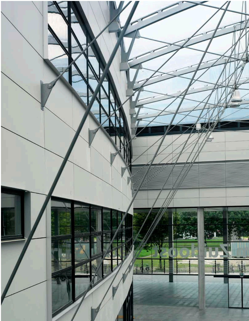
De staalconstructie is slank uitgevoerd zodat het dak zo transparant mogelijk kan zijn. The steel structure was kept slender in the interests of maximum transparency.
