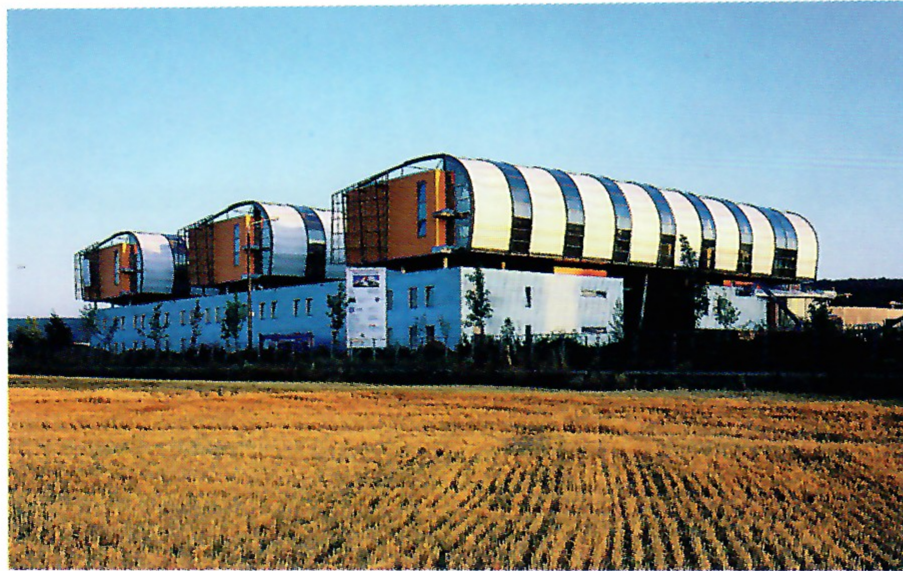
Ansicht von Norden mit Blick auf die Membranfassaden
