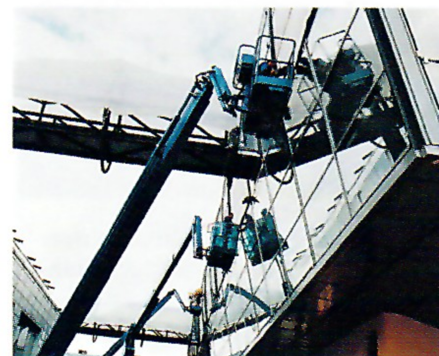
Montage der Glasfassade
