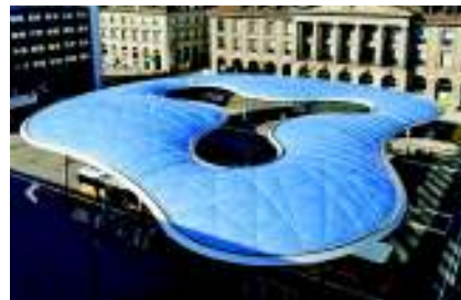
Figure 12. M.Vehovar & S.Jauslin Architektur, 2014: Aarau bus terminal
